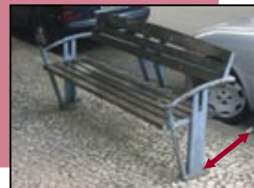
Figura 193 – Banco implantado próximo ao meio-fio, criando uma ambiência interna ao passeio, mas podendo trazer problemas com as portas dos carros ao se abrirem.
