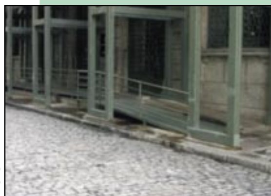
Figuras 131 - Rampa metálica removível, acoplada a edificação histórica para não se descaracterizar a edificação e permitir o acesso de usuários de cadeiras de rodas.
