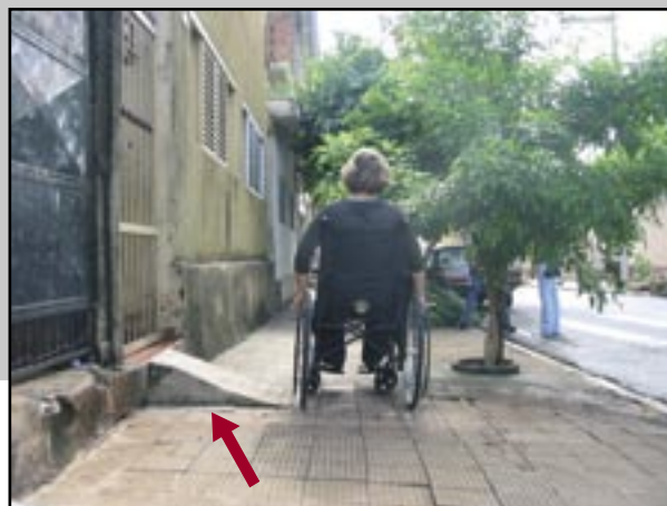
Figura 239 – Morador implanta rampa de acesso a seu imóvel sobre a calçada provocando, além do obstáculo na travessia longitudinal, um estreitamento da calçada.
