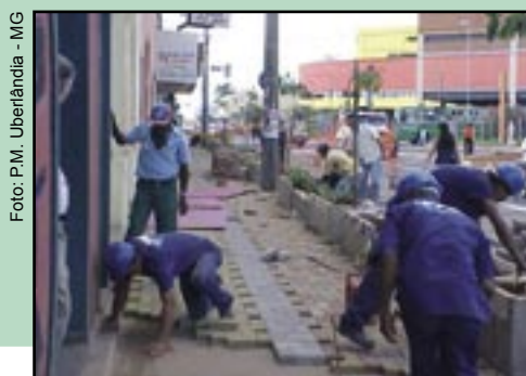
Figura 162 – Construção de calçada em Uberlândia-MG com o conceito de acessibilidade contendo piso tátil de orientação .
