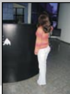
Figura 139 - Altura de balcão de atendimento, prejudicial para uma pessoa de baixa estatura e inacessível a uma pessoa em cadeira de rodas.
