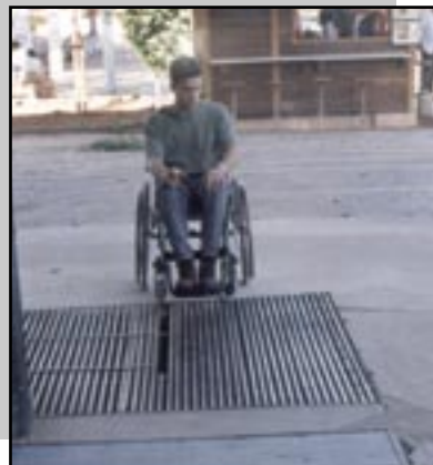
Figura 005 - Grelha de proteção no piso danificada impedindo a circulação de cadeira de rodas.
