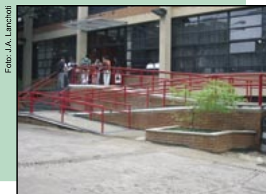
Figura 166 – Rampa de acesso a biblioteca de uso público com inclinação correta conforme ABNT NBR 9050:2004.
