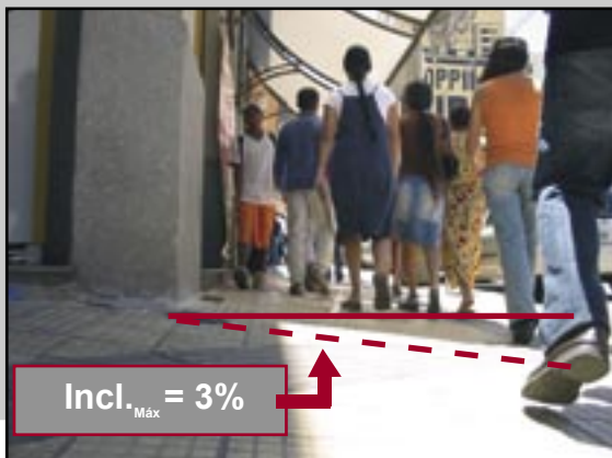
Figuras 250 e 251 – A inclinação transversal da calçada acima de 3% dificulta e até impede a circulação com autonomia e segurança para pessoas usuárias de cadeiras de rodas, idosos, usuários de muletas, grávidas, enfim, a um público variado que sofre com a falta de equilíbrio ou se utiliza de aparelhos para auxiliarem na locomoção.
