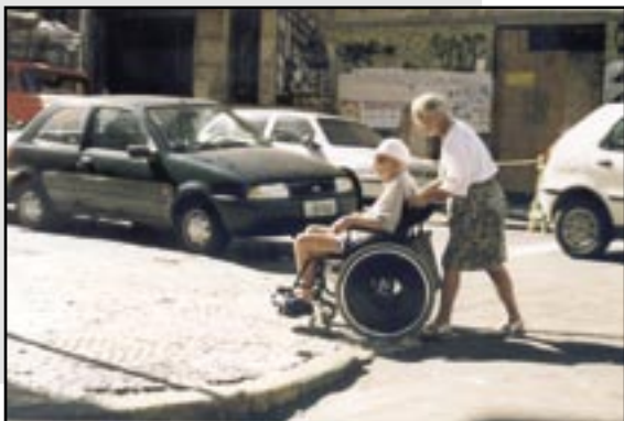
Figura 313 – A instalação das rampas deve estar no sentido da travessia, permitindo maior segurança e levando em consideração que há uma inúmera realidade de pessoas com limitações diversas. Na foto percebe-se uma senhora idosa conduzindo um senhor idoso em cadeira de rodas por uma rampa mal conservada.
