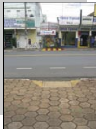
Figura 249 – Alguns pisos embora pareçam uniformes e identifiquem uma determinada textura diferenciada, acabam se transformando em obstáculos na circulação de pessoas devido a descontinuidade de sua implantação (assentamento).
