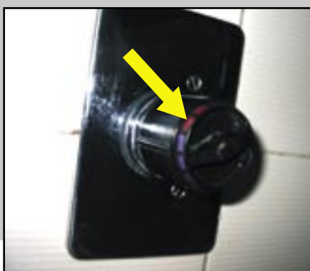
Figura 145 – Sistema de acionamento de água de chuveiro em hotel que necessita da mobilidade total das mãos e da visão para identificar a determinação da temperatura por intermédio da cor.
