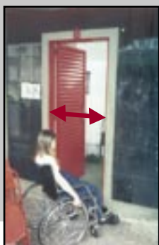
Figura 088 – Largura estreita de porta de sanitário em local de trabalho.
