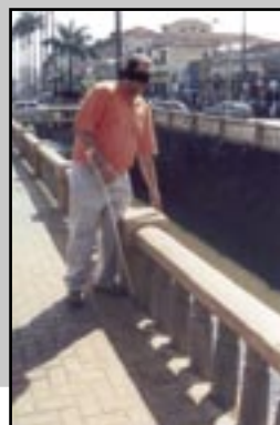
Figura 124 - Mureta de proteção de rio baixa demais, podendo provocar acidentes.
