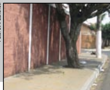
Figura 122 - Vegetação implantada de forma equivocada, resultando em inaccessibilidade na circulação de pessoas.
