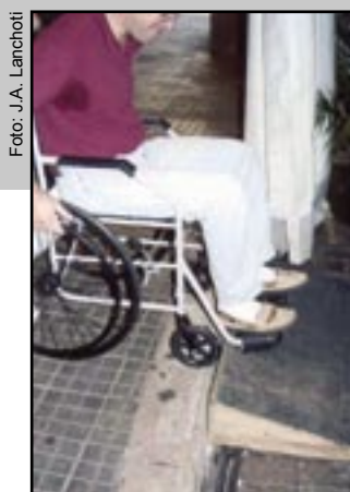
Figura 046 – Situação inaceitável de falsa acessibilidade devida o imprevisto – perigoso – de uma rampa não fixa.
