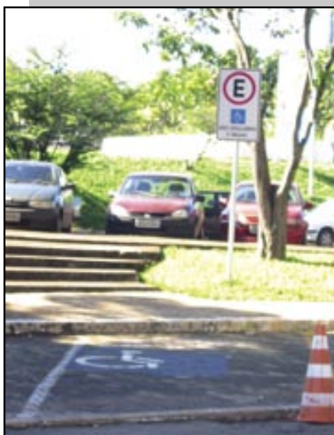
Figura 323 – A implantação de vagas reservadas para veículos que conduzem ou são conduzidos por pessoas com deficiência não pode ter desníveis acima de 1,5cm.
