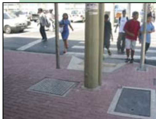
Figura 228 – Tampas de acesso à infra-estrutura instaladas sobre a calçada sem nenhuma saliência que provoque desconforto no usuário do espaço urbano.
