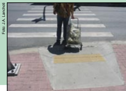
Figura 165 – Rampa de acesso à calçada construída com o conceito da acessibilidade na cidade de São Paulo, com inclinação correta e piso de alerta em sua base.
