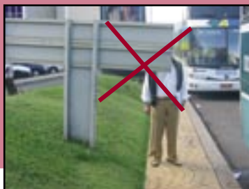
Figura 191 – Placa de indicação de logradouro com partes projetadas sobre o passeio público e que não seriam detectadas por pessoas com deficiência visual (ou pessoas desatentas), podendo ocorrer acidentes.
