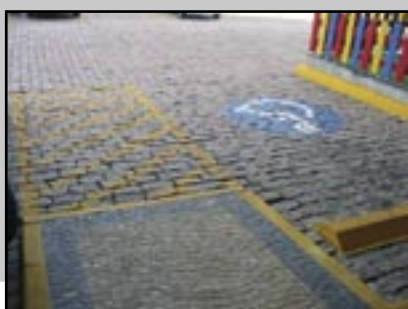
Figura 141 – Estacionamento reservado para veículos que conduzem pessoas com deficiência com piso totalmente inadequado para a circulação de cadeira de rodas.
