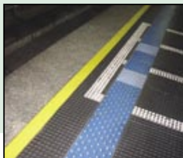
Figura 332 – Demarcação de rota acessível no Metrô paulista, indicando o ponto de embarque ao trem com a ajuda do piso tátil.
