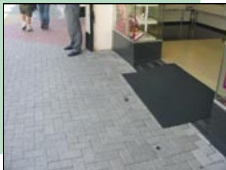
Figura 243 – Acesso a estabelecimento comercial com rampa suave. Deve se evitar a colocação de tapetes ou capachos com espessuras superiores a 1,5cm e que não sejam aderentes ao piso.
