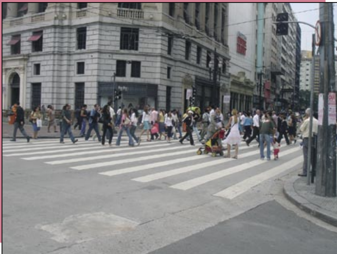
Figura 277 – Cruzamento de vias com travessia de pessoas, faixas de travessia e rampas de rebaixamento de calçada com piso tátil de alerta.
