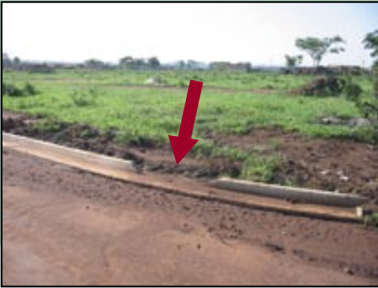
Figura 114 - Novo loteamento com guia rebaixada desde sua implantação, facilitando a construção de rampas e permitindo uma redução no custo das adaptações.
