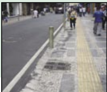
Figura 331 – Demarcação de rota acessível em rua comercial. Garantirá de não haver obstáculos no trajeto e passando por pontos comerciais.
