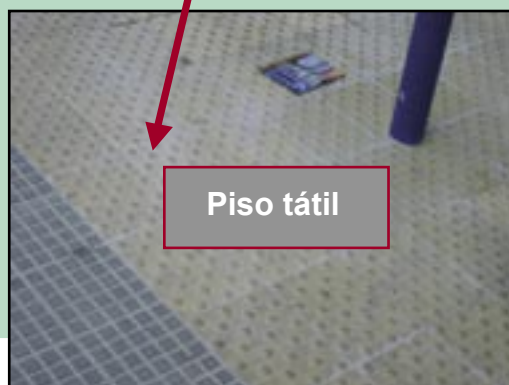
Figura 216 e 217 – Piso tátil com cor diferenciada alertam para a existência de mobiliário urbano preso em um único suporte e projetado sobre o passeio.
