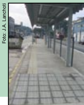
Figura 163 – Baía de embarque de corredor de ônibus na cidade de São Paulo com piso tátil de orientação.
