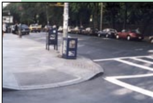
Figuras 308 e 309 – Duas rampas de travessia em cada esquina, com dimensões mínimas e na direção do fluxo.
