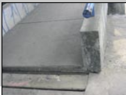
Figura 138 - Degrau seguido de base não rígida de madeira, após uma rampa, impedindo o acesso de cadeira de rodas.
