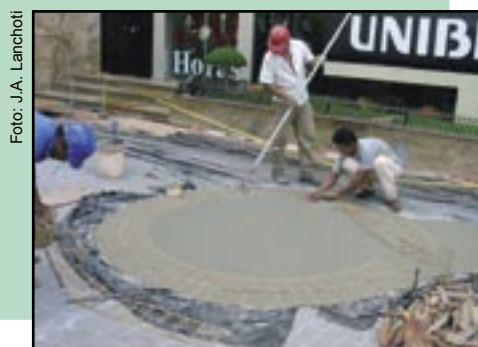
Figura 164 – Construção de calçada exclusiva para pedestres em Ribeirão Preto – SP com piso tátil de orientação da localização de mobiliário urbano.
