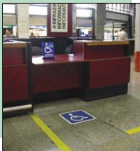
Figura 338 – A correta colocação do Símbolo Internacional de Acesso nesta parte mais baixa do balcão de atendimento indica a possibilidade de atendimento a uma pessoa com deficiência.
