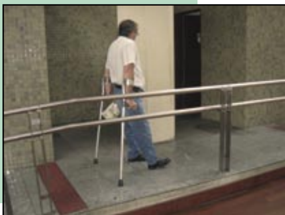
Figura 009 – Usuário de muletas tipo canadense acessando edificação com rampa adequada com corrimão em alturas corretas.
