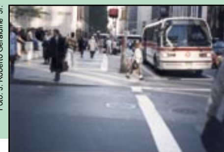
Figura 311 – Situações onde a quina da esquina é totalmente rebaixada pode significar uma economia em relação a não ter duas rampas por esquina, mas a segurança não é garantida às pessoas com deficiência visual que acabam não tendo referências ao cruzamento.
