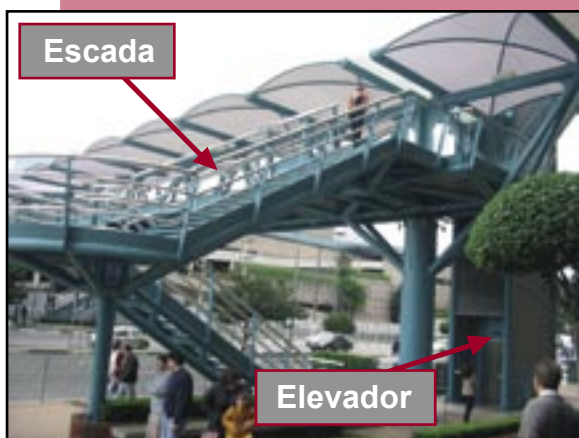
Figura 299 – Travessia de pista de grande fluxo de veículos por intermédio de rampa acessada por escada e elevador.
