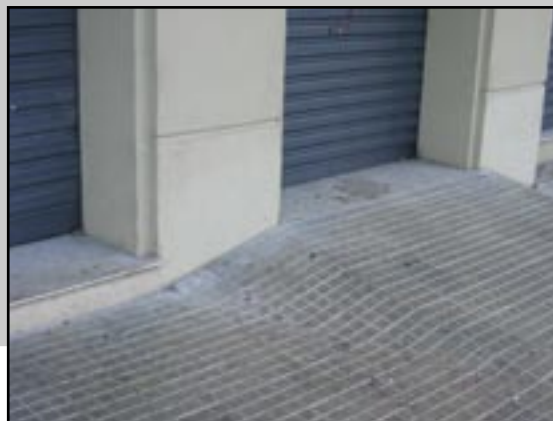
Figura 246 e 247 – Acesso ao estabelecimento comercial através da inclinação do piso da calçada acima do permitido pela Norma (máximo para áreas externas é 3%). Típico exemplo da transferência para a área pública do problema gerado pelo equívoco do projeto particular ou de sua execução.
