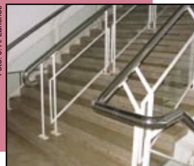
Figura 330 – Corrimão contínuo com curvas arredondadas suavizando o correr das mãos, o que aumenta a segurança e o equilíbrio dos usuários, principalmente em casos de fuga.
