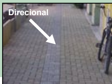
Figura 261 – Instalação de piso tátil direcional no meio do passeio público para facilitar o percurso de pessoas com deficiências visuais.
