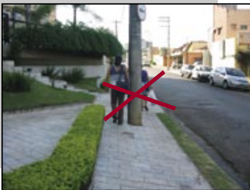
Figura 198 – Mobiliário instalado no meio do passeio público e inclinação do passeio fora da NBR.
