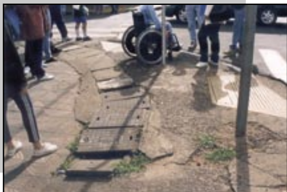
Figura 227 – Muitas vezes a falta de manutenção dos elementos transforma o local inacessível. A instalação de placas de visita às galerias de infra-estrutura deve receber, além de atenção especial na sua implantação, uma constante manutenção.
