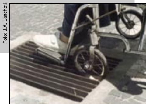
Figura 048 – A grelha implantada no espaço urbano possui vãos maiores do que o estabelecido na Norma, possibilitando acidentes.
