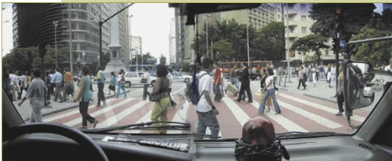
Foto 8 - Faixa semi-elevada com utilização da cor vermelha no fundo e rebaixamento das guias do calçamento de pedestres. Praça 7, Belo Horizonte, 2004.
