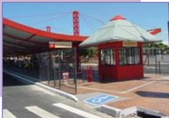
Terminal de Integração Zona Sul
