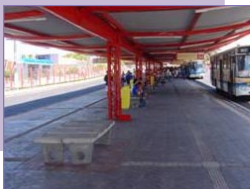
Rampas e Piso Tátil
