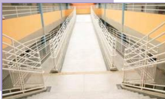
Rampa de acesso às salas de aula
