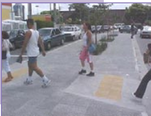
Travessia rebaixada com piso tátil
